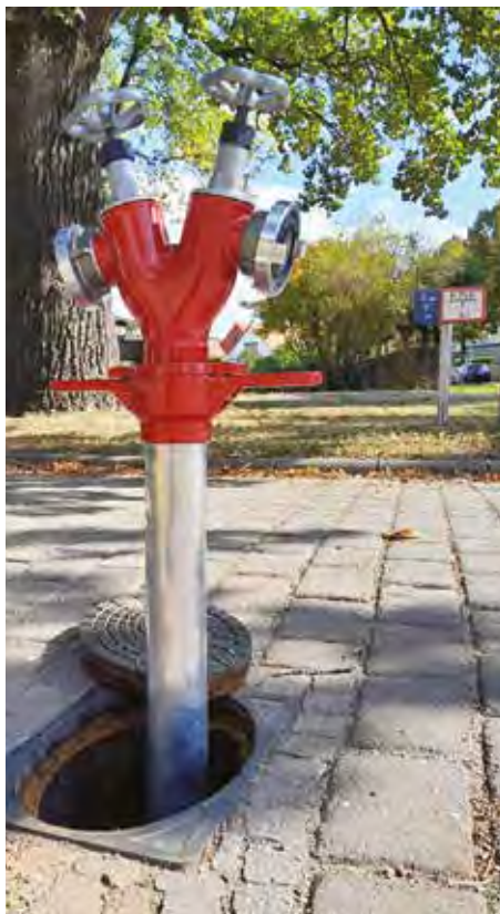
Ein Unterflurhydrant – hier mit Standardrohr – ist direkt ans Trinkwassernetz angeschlossen. Im Hintergrund ist ein rot-weißes Schild zu sehen, das Hinweise zur Lage des Hydranten gibt.
