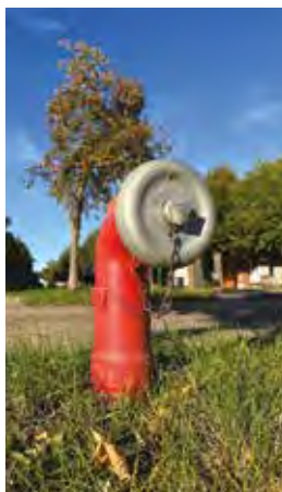
Ein Unterflurhydrant – hier mit Standardrohr – ist direkt ans Trinkwassernetz angeschlossen. Im Hintergrund ist ein rot-weißes Schild zu sehen, das Hinweise zur Lage des Hydranten gibt.
