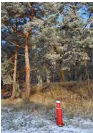
Ein Unterflurhydrant – hier mit Standardrohr – ist direkt ans Trinkwassernetz angeschlossen. Im Hintergrund ist ein rot-weißes Schild zu sehen, das Hinweise zur Lage des Hydranten gibt.
